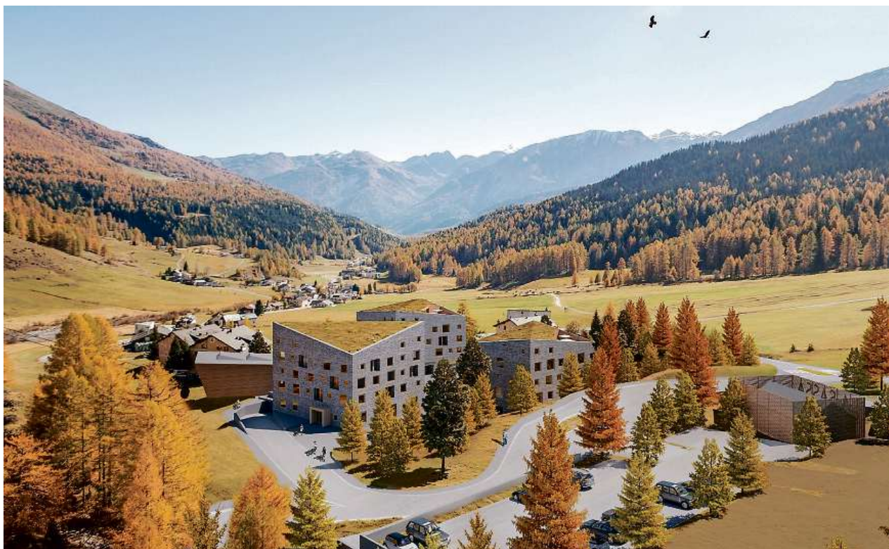
Ein Ensemble, das einen Dorfplatz bilden soll: So sieht das neue Ferienresort «La Sassa» in Tschierv aus.
